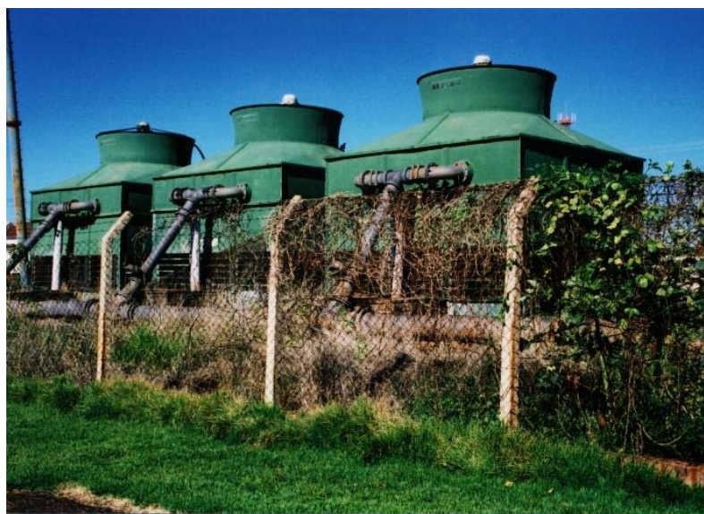
Figura 4. Resfriadores utilizados para rebaixar a temperatura da água captada de poços em São José do Rio Preto
