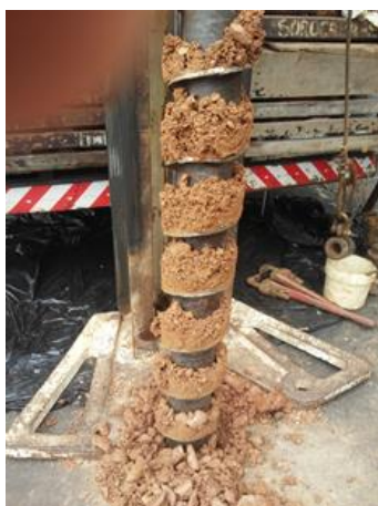
Figura 4. Trados helicoidais ocos com solo proveniente da perfuração
