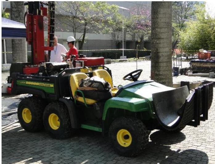
Figura 4 - Sonda AMS-Power Probe 9100-ATV durante campanha de ensaios in situ
