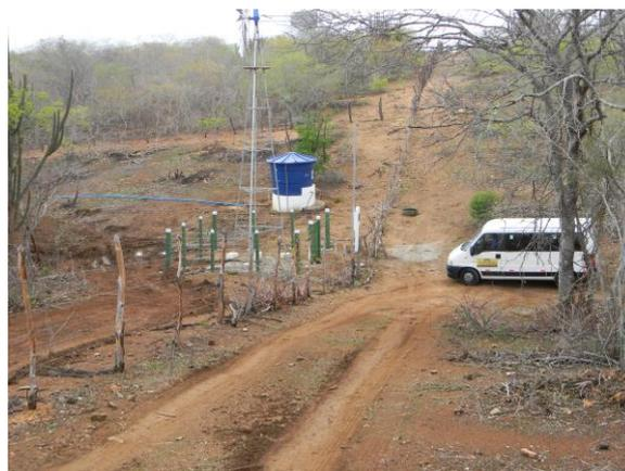
**Figura 2:** Poço de água subterrânea bobeadado através de catavento.
