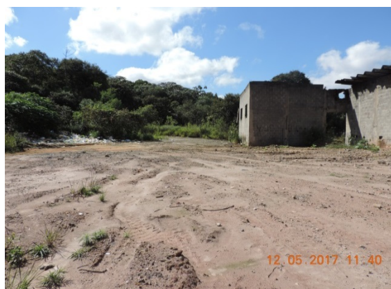
Figura 2 – Foto Área Externa - Depois
