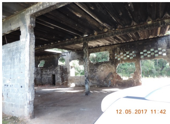
Figura 4 – Área Interna Galpão - Depois
