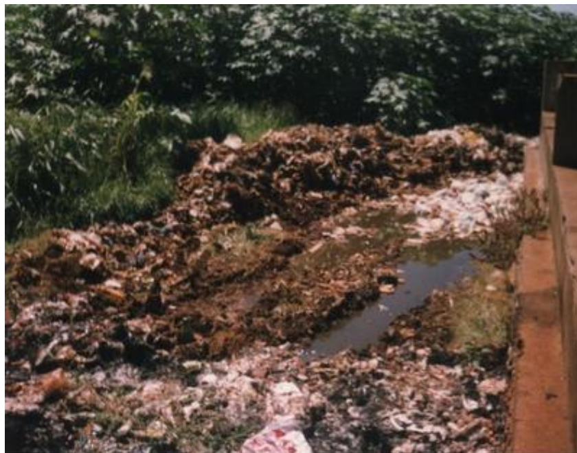
Figura 9 – Ausência de drenos condutores de chorume, águas superficiais e gases. Fonte: Melo (1999).
