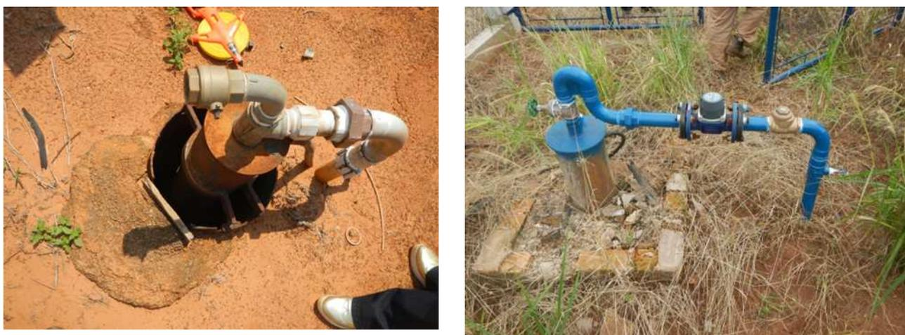
Figura 11. Exemplos de poços sem selo sanitário e laje de proteção danificada.
