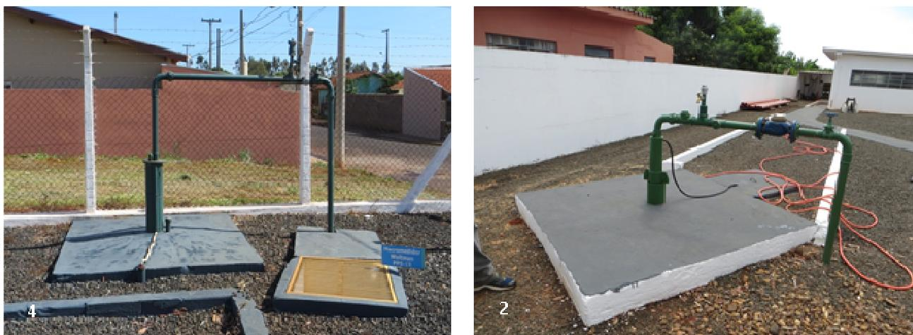
Figura 10. Exemplos de poços em boas condições de proteção sanitária.
