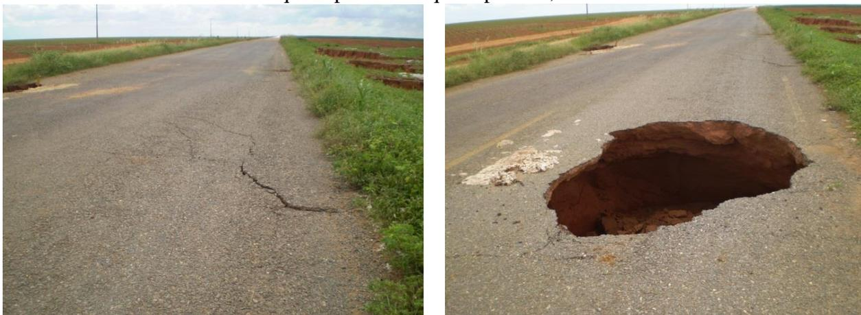
Fotos 1 e 2. Linha de depressão superficial e duto em estrada de asfalto na BA-459
