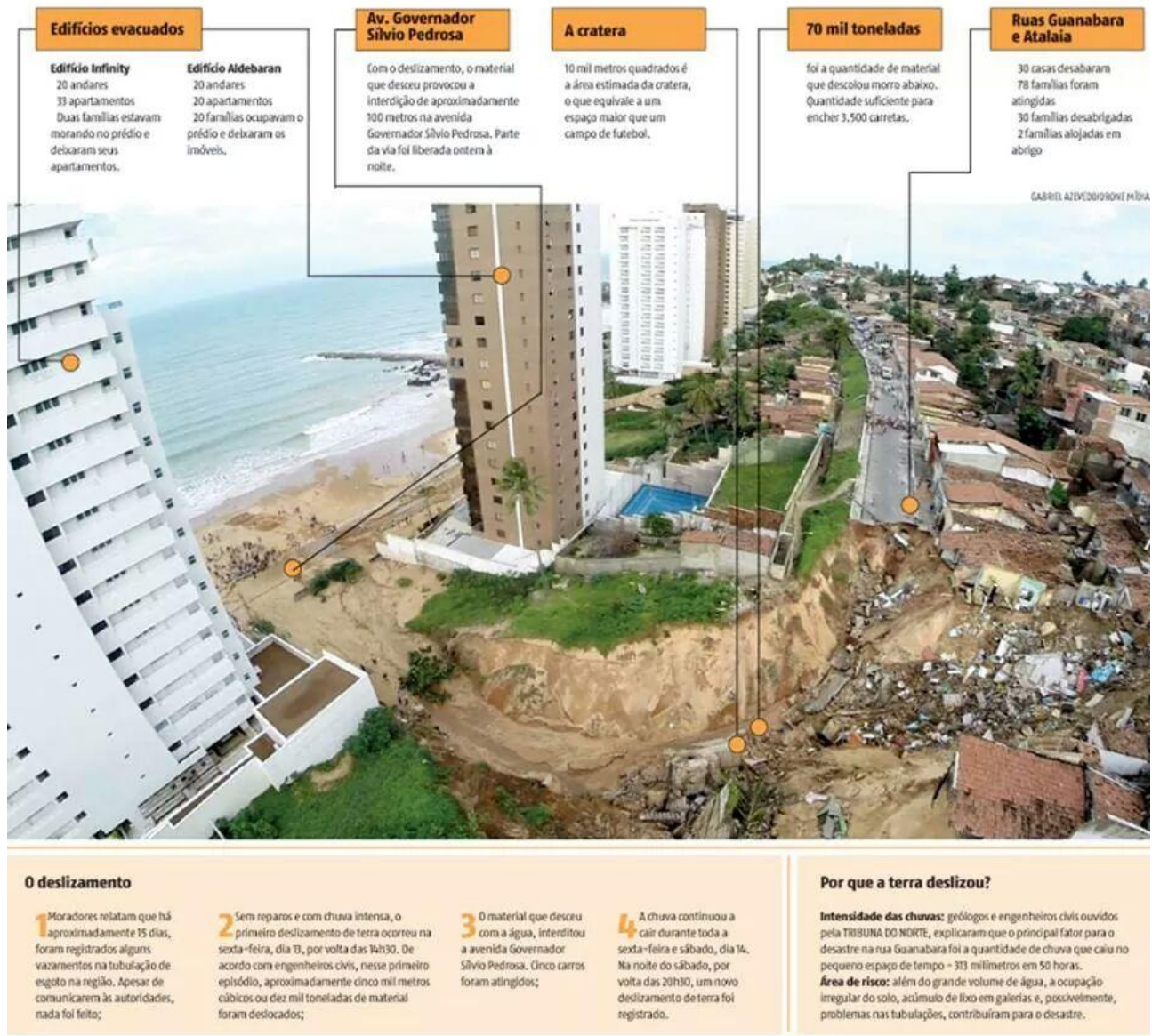
Figura 9. Deslizamento de solo abriu cratera comprometendo 34 casas (Mãe Luíza). Classe Alto Risco Potencial a Movimentos de Massa.
