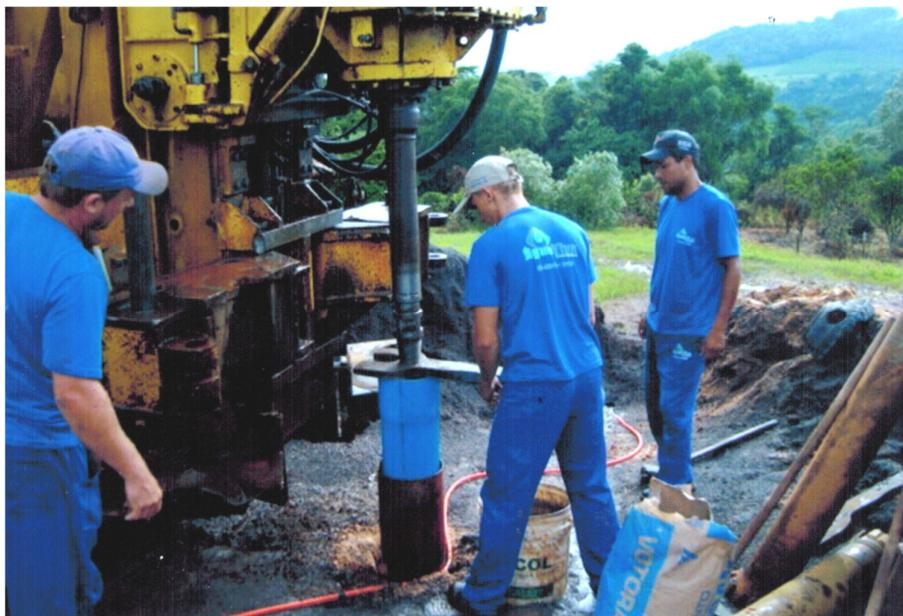
Figura 6: Colocação de tubulação de revestimento
