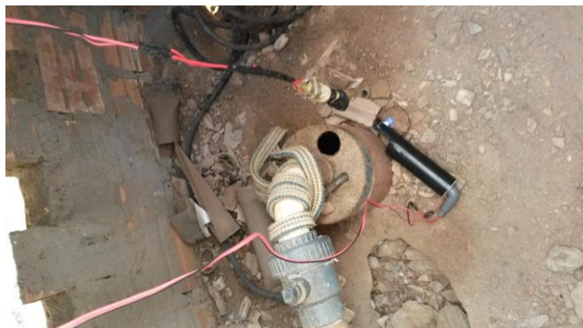
Figura 02. Medida do nível piezométrico do poço 01 do microssistema de abastecimento público de água do bairro Urumari. Foto: Lucas Meireles.
