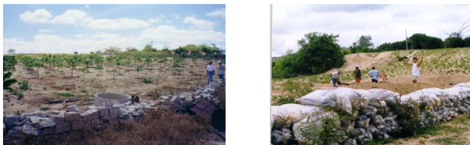
Figura 7 – Enrocamento de pedras à esquerda e com sacos de areia à direita
