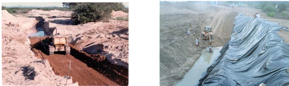
Figura 5 – À esquerda colocando o septo de argila e à direita a lona impermeável e em outra barragem.
