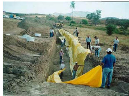
Figura 3 – Abertura da vala a esquerda e colocação da lona impermeável para construção da barragem subterrânea.
