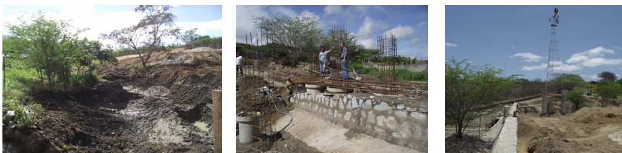
Figura 9 – À esquerda aspecto do vale antes da intervenção; no centro detalhe da construção da barragem de pedra com armação metálica; à direita o enchimento do reservatório com areia, vendo-se o poço amazonas dotado de catavento para bombeamento da água a ser acumulada.
