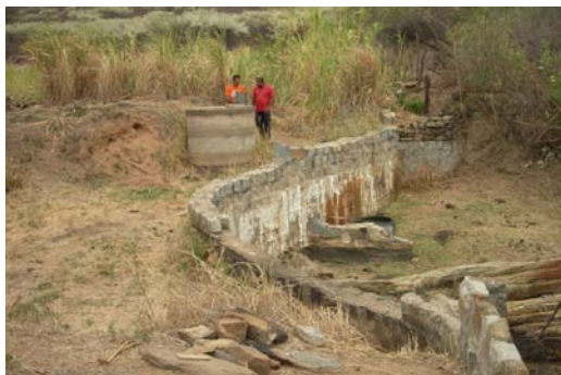
Figura 4 – Barragem de assoreamento natural à esquerda e artificial à direita
