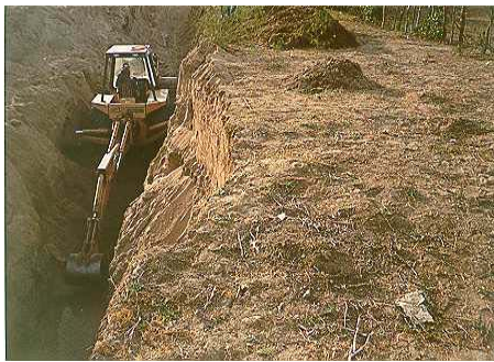
Figura 3 – Abertura da vala a esquerda e colocação da lona impermeável para construção da barragem subterrânea.
