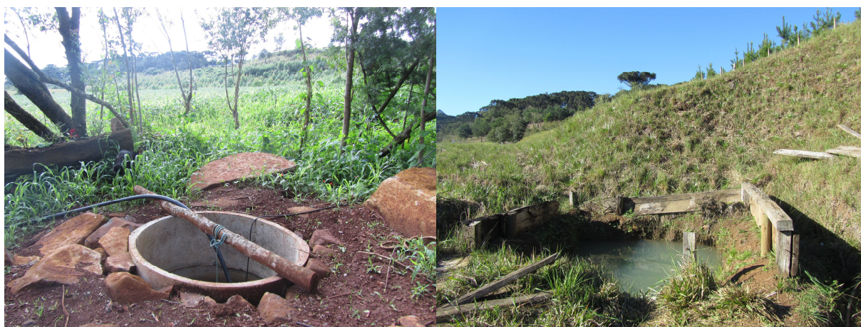
Figura 2. Representação dos diferentes poços de água subterrânea presentes na área de estudo. À esquerda poço de manilha (tipo cisterna) e à direita poço de vertente.
