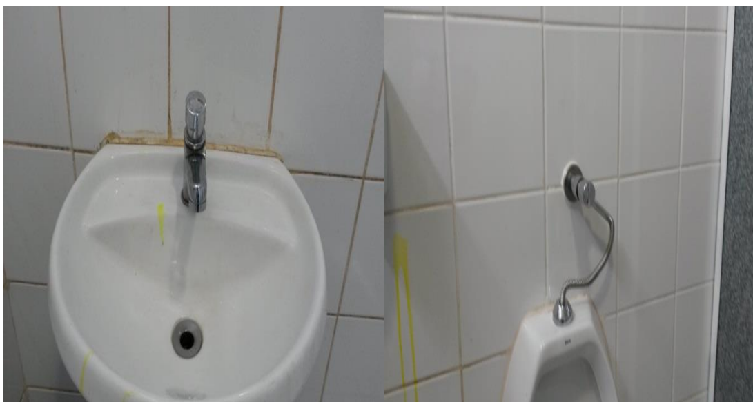
Foto 07 – dispositivos redutores de consumo de água
