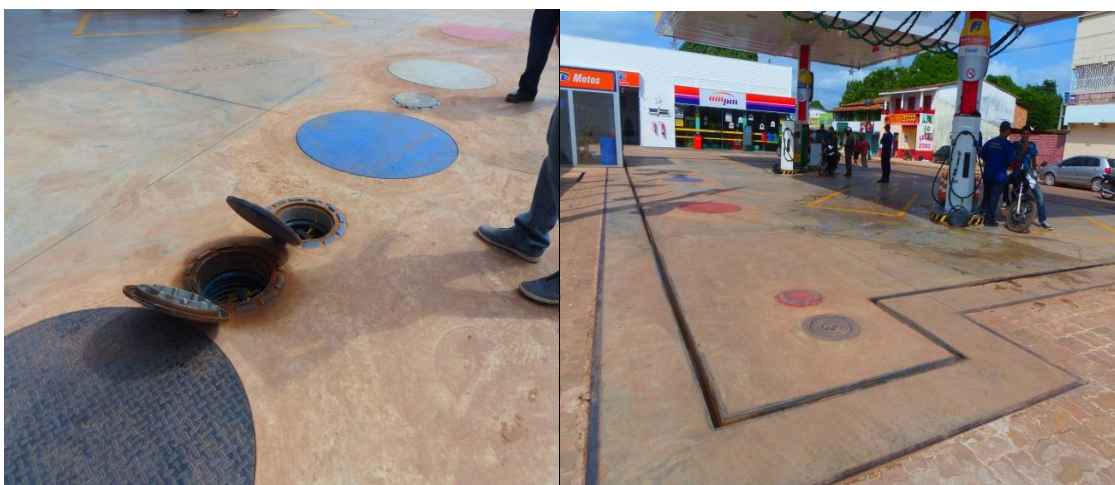
Foto 05 – Outros dispositivos de Proteção Ambiental / Treinamento Preventivo como; poços de monitoramento, tanques enterrados, canaletas de contenção, entre outros.
