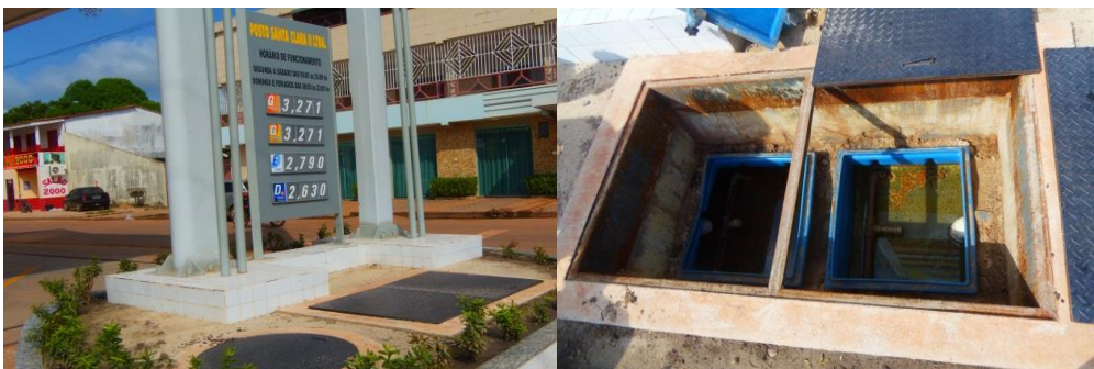
Foto 06- Caixa Separadora Água e Óleo do Posto
