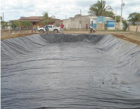
Figura 7. Tanque de rejeito pronto na localidade de Sítio Salobro município de Pesqueira-PE. Fonte: ITEP/OS, 2014
