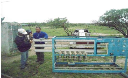
Figura 4. Recuperação do sistema de dessalinização na localidade de Sitio Piado Capoeiras ó PE. Fonte: ITEP/OS, 2014
