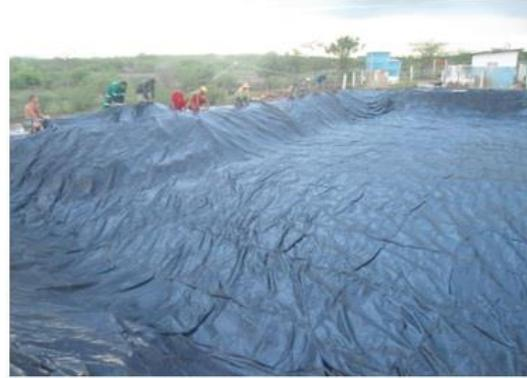
Figura 8. Revestimento do tanque com lona (gel membrana) impermeável, na localidade Sítio Bento município de Riacho das Almas - PE. Fonte: ITEP/OS, 2014
