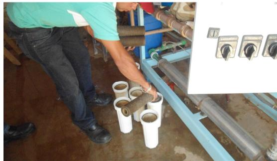
Figura 5. Manutenção do sistema de dessalinização na localidade Vila do Pará - Stª. Cruz Capibaribe ó PE. Fonte: ITEP/OS, 2014
