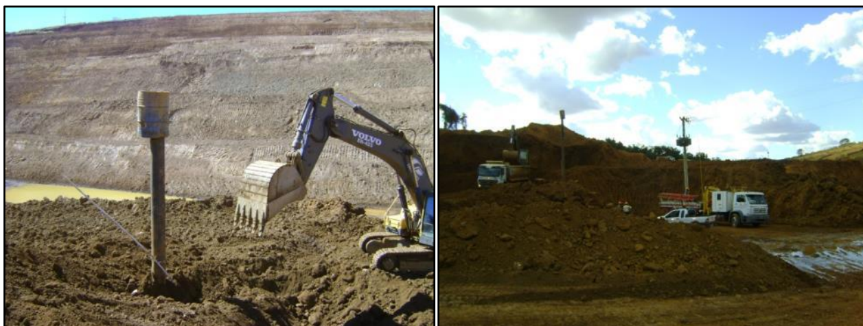
Figura 17 – (esq.) Avanço da lavra em volta do poço mantendo ele sempre a parte superior revestimento fechada/ (dir.) Reinstalação da parte elétrica e postes (Fonte: Vale Fertilizantes).
