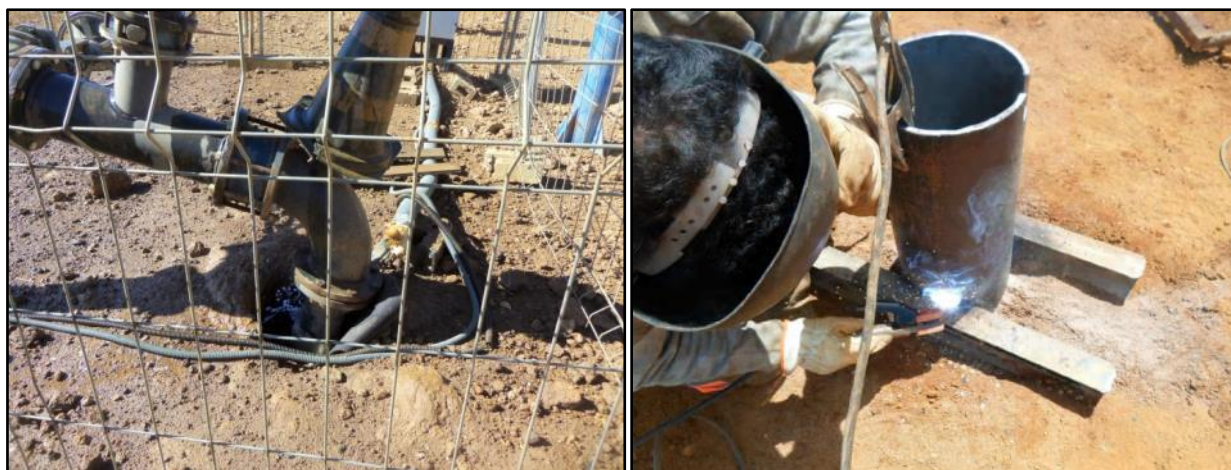
Figura 20 – (esq.) O poço PP-5 da mina f4 quando ocorreu rebaixamento do revestimento/ (dir.) Soldagem da viga para fixação do revestimento, substituindo a cimentação (Fonte: Arquivo pessoal).
