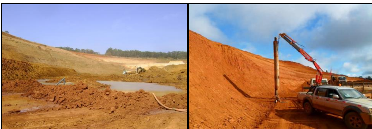
Figura 18 – (esq.) O poço PAP-6 com surgências no piso após 3 meses com ele parado para avanço de lavra / (dir.) Auxílio do caminhão munck para recorte do revestimento (Fonte: Vale Fertilizantes).
