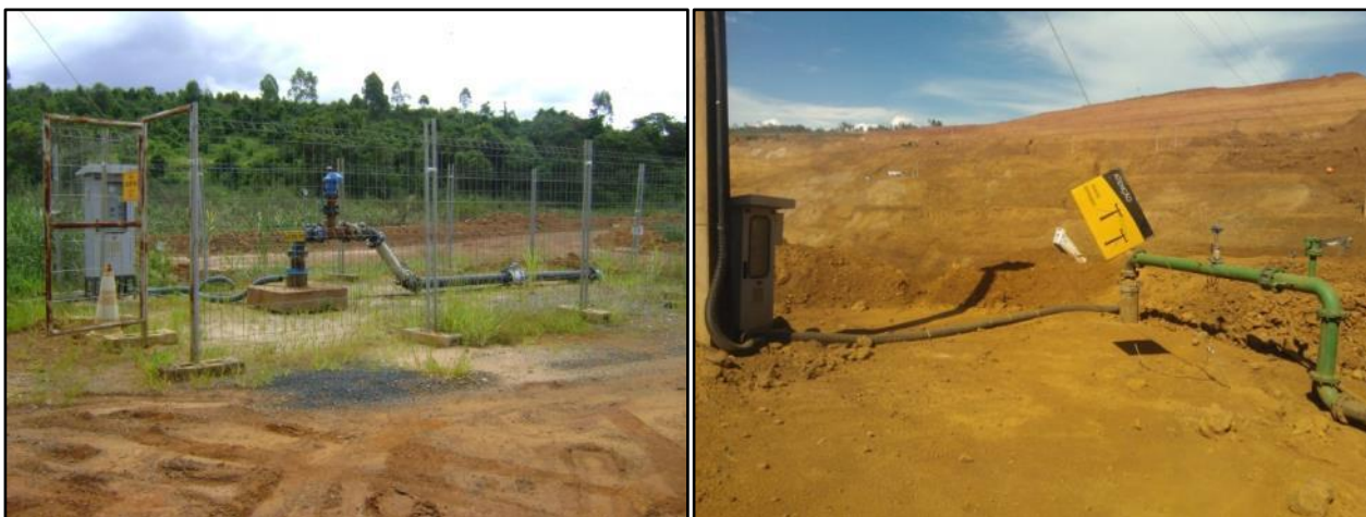
Figura 16 – (esq.) O poço PP-4 da mina f4 antes dos recortes em fevereiro de 2013/ (dir.) O poço PP-4 após os 60m previstos de recorte em fevereiro de 2014 (Fonte: Vale Fertilizantes).
