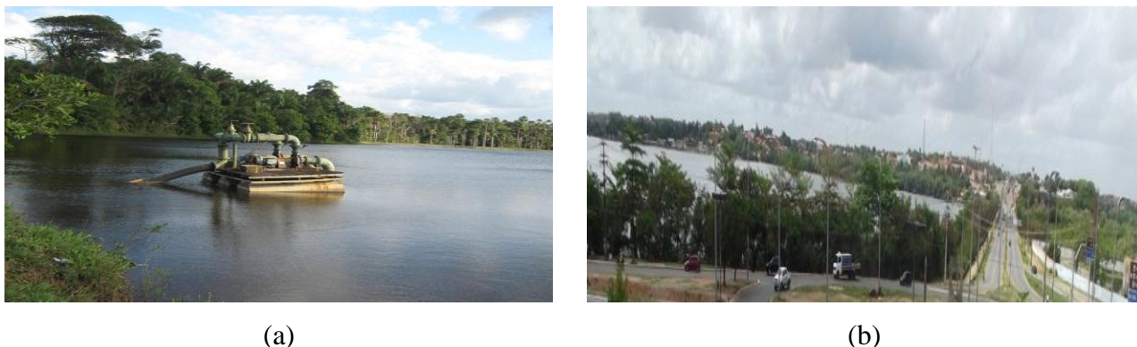
Figura 2 – (a) Bomba transportando água do Rio da Prata para o reservatório do Batatã. (b) Reservatório do Batatã.
