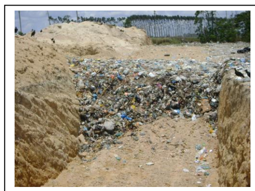
FIGURA 2 : Detalhe do enleiramento do lixo
