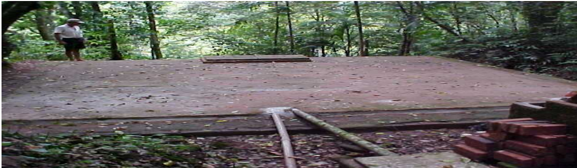
a 02: Reservatório de água, captação oriunda de nascente – Sistema abastecimento de Monte Alverne.
