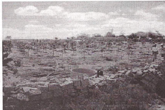
Enrocamento de pedras vendo-se o plantio de mamão a montante da barragem
