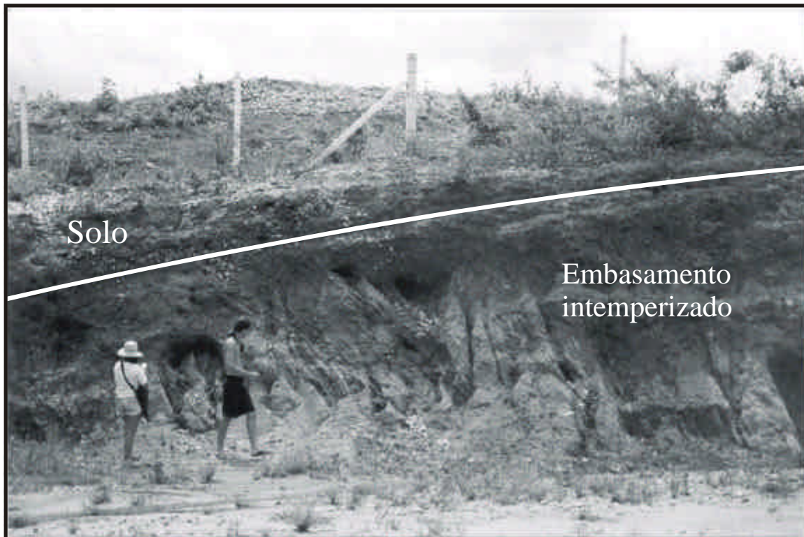
Fig. 2. Afloramento de rochas gnaíssicas intensamente intemperizadas, subjacente a fina camada de solo arenoso. Margem esquerda da Rodovia Estruturante (CE-085) no sentido Fortaleza - Paracuru. Coordenadas geográficas: 3° 36' 27" S e 38° 56' 58" W.
