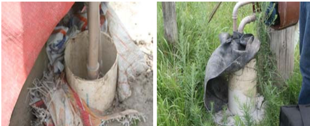
Figura 12 – Poços a Trado cadastrados na etapa de levantamento de campo.
