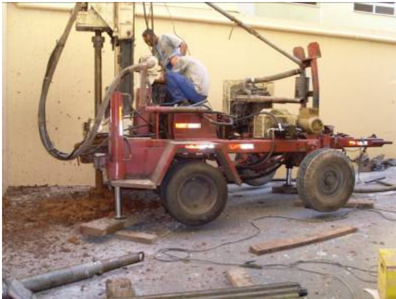
Figura 2: Perfuração de poço na Formação Serra Geral, entrada da garagem de condomínio residencial em Chapecó, SC, em maio de 2008. (Foto Luiz Fernando Scheibe).
