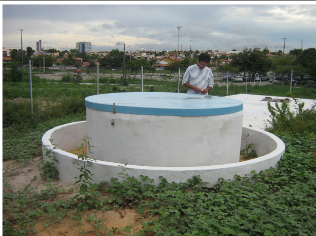
Figura 3: Poço amazonas. Fonte: Mariana Magna S. da Nóbrega.
