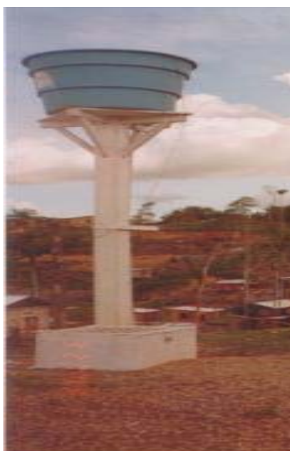
Figura 3 - Poço analisado na invasão Campos Sales
