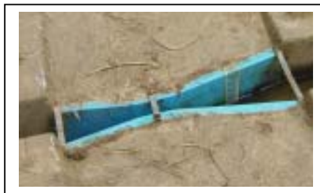
Foto 13 – Calha de medição de vazão
