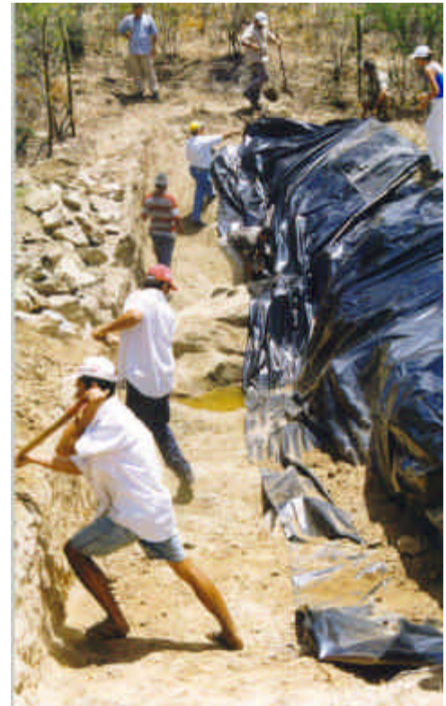
Figura 3.1 – Construção de uma barragem subterrânea rasa.
