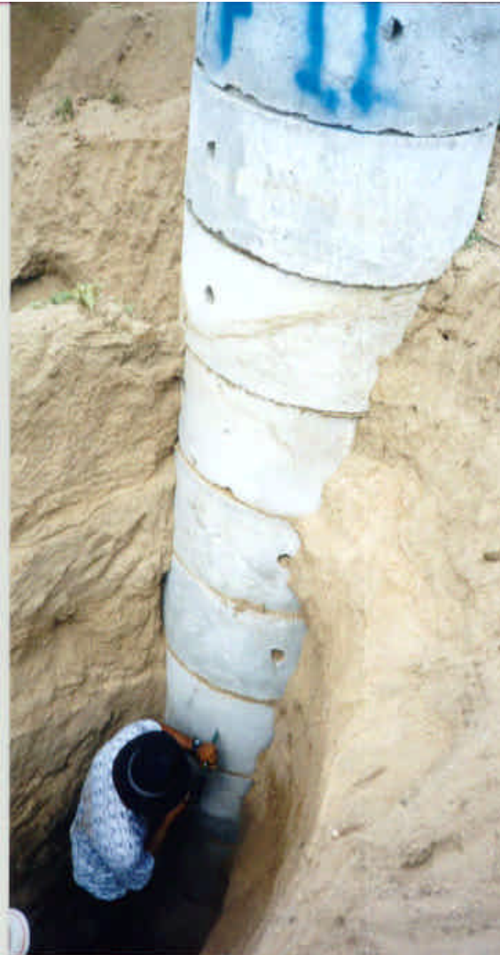
Figura 3.5 – Perfuração dos anéis do poço amazonas feita por fora do revestimento.
