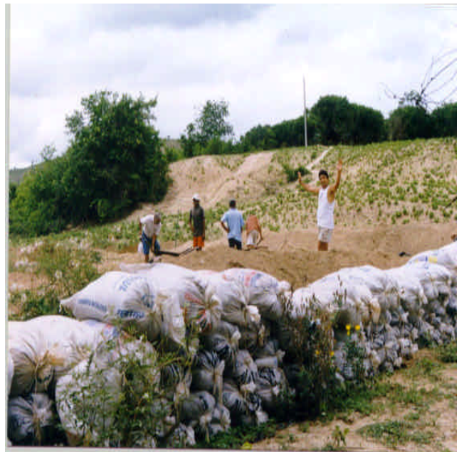
Figura 3.3 – Enrocamento com sacos de areia
