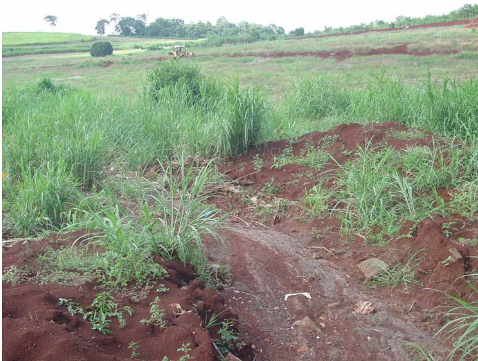
Foto 2. Área abaixo da manilha com evidências de alteração do relevo.
