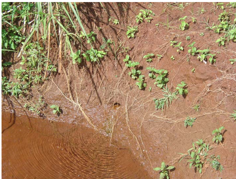
Foto 3. Surgência ocorrida na área escarificada ou escavada.
