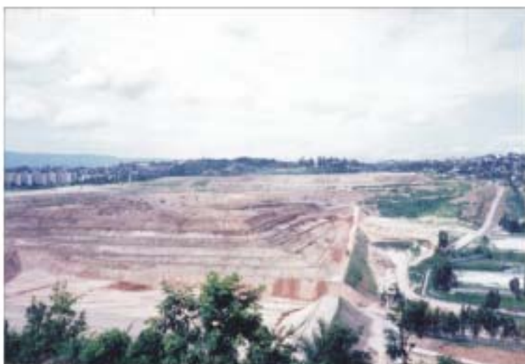
FOTO 8 - Aterro sanitário parcialmente concluído, faltando a revegetação que foi iniciada no talude mais inferior.
