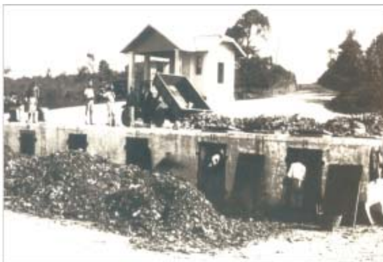
FOTO 1 - Antigas células de deposição e incineração do lixo no sistema Baccari (foto da Prefeitura Municipal de Belo Horizonte de 1960)
