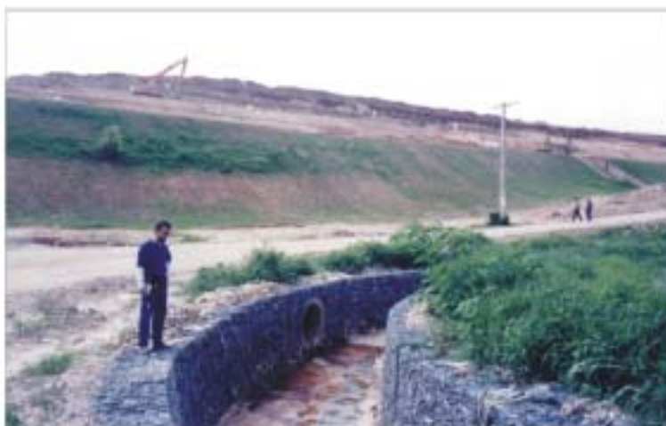
FOTO 9 - Saída do chorume do aterro sanitário, que é direcionado "in natura" através de canais até as cabeceiras da drenagem local
