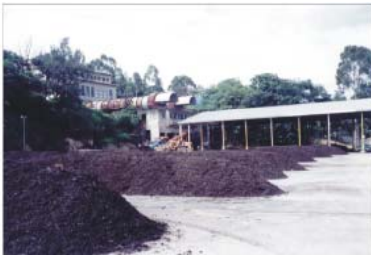
FOTO 7 - Usina de compostagem do lixo instalada no Aterro Sanitário, vendo-se em primeiro plano, pilhas do lixo já tratado.
