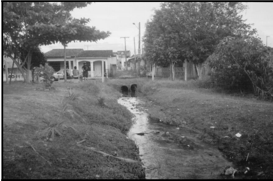
Figura 6 - Precariedade do sistema de saneamento básico em um bairro localizado na cabeceira do Lago Bolonha (Bordalo, 2006).
