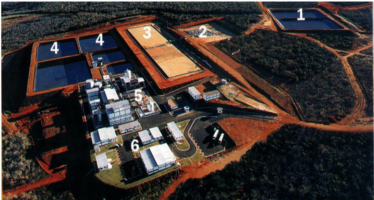
Figura 1 – Localização das principais jazidas uraníferas conhecidas no Brasil, com destaque para a província de Lagoa Real e a planta da Unidade de Concentração de Urânio (URA): 1 – Tanques de efluentes; 2 – Britador; 3 – Pátio de lixiviação; 4 – Tanques de licor; 5 – Área Industrial e 6 – Área Administrativa.
