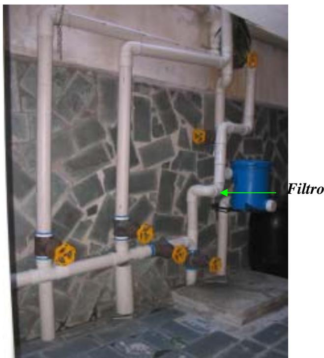
**Figura 2** – Sistema de captação das águas pluviais e filtro.
