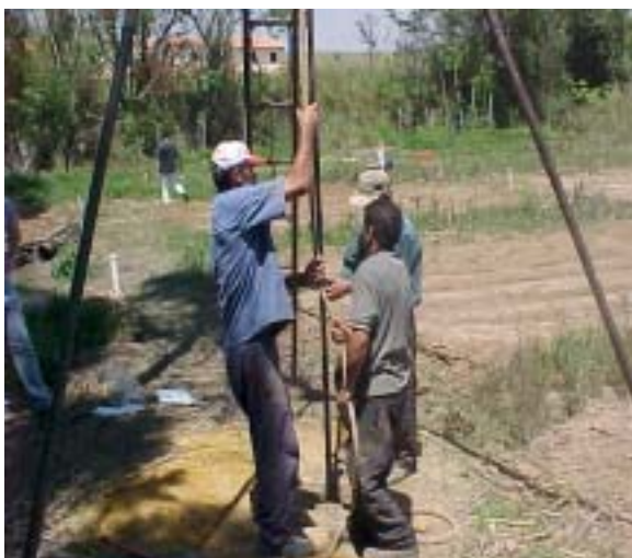
Figuras 4 - Perfuração, Instalação (esq.) e Disposição dos Poços de Monitoramento (dir.).
