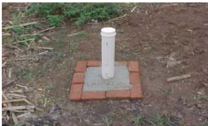
Figura 5 - foto da cimentação dos poços.
