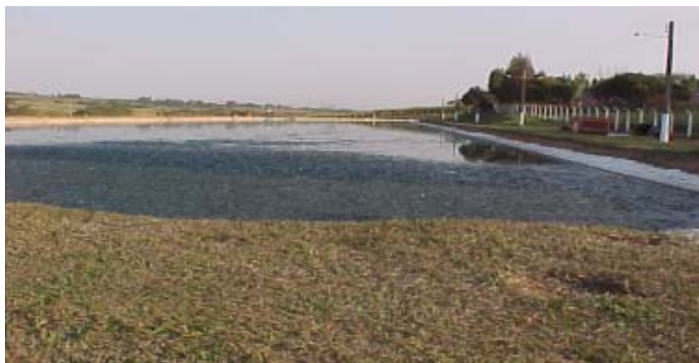
Figura 2- foto da lagoa anaeróbica da E.T.E. Graminha.
