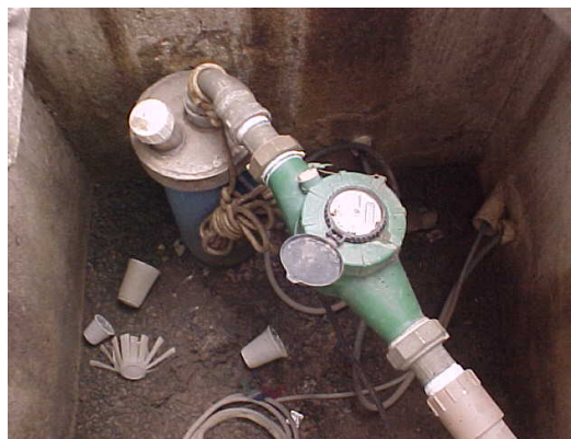
Fotos 06 e 07. Detalhe do poço tubular “air-lift” e poço tubular equipado com bomba submersa e hidrômetro.
