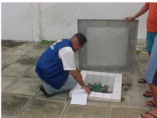
Fotos 02 e 03. Leitura de hidrômetro e identificação de registro do mesmo.
