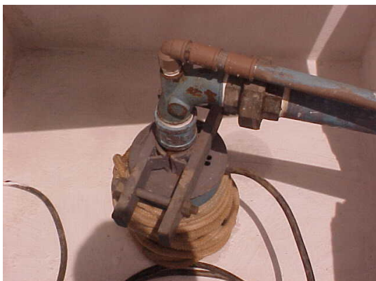
Fotos 06 e 07. Detalhe do poço tubular “air-lift” e poço tubular equipado com bomba submersa e hidrômetro.
