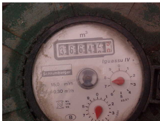
Fotos 02 e 03. Leitura de hidrômetro e identificação de registro do mesmo.
