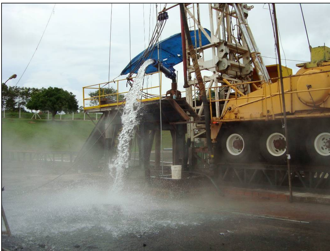
Figura 13. Detalhe do teste de bombeamento.
