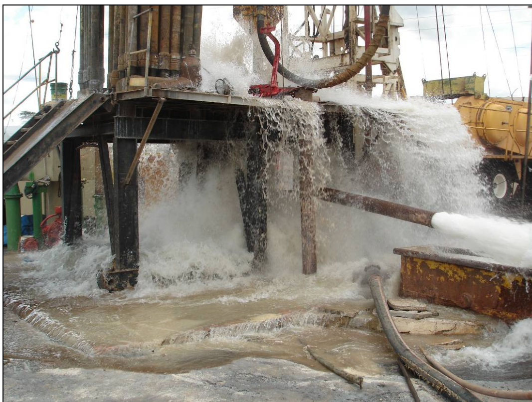
Figura 12. Detalhe do bombeamento final, após a aplicação do desincrustante, sem a interrupção da produção de água (regime contínuo), com vazão estimada de 350 a 400 m 3 /h.
