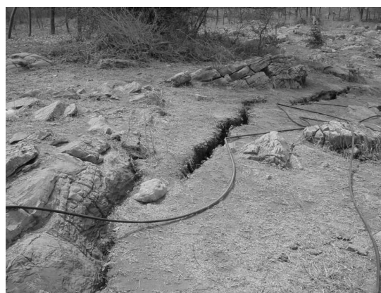
Figura 2 – Fissuras no solo na Fazenda Juá.
