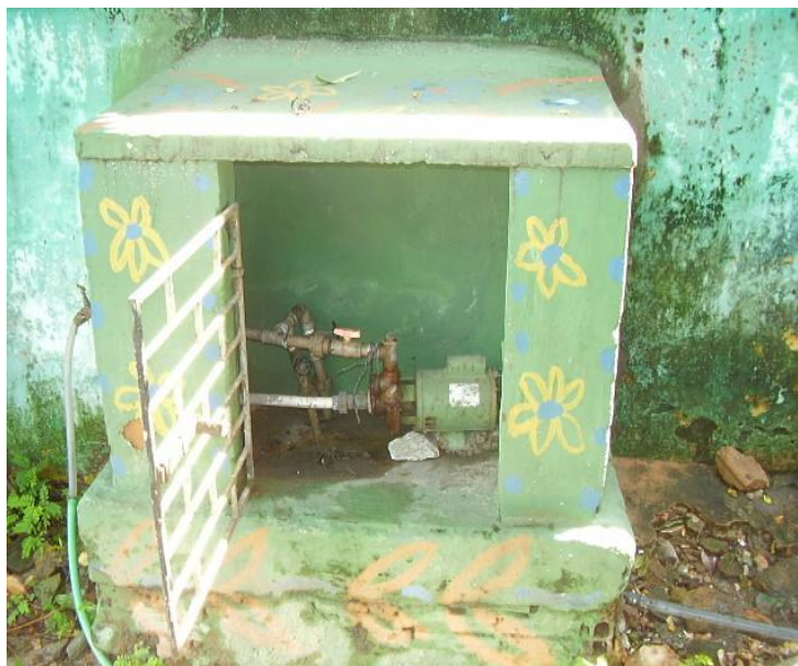
Foto 01. Visualização do poço tubular no bairro Cristo Redentor/Fortaleza-CE, mostrando em detalhe o abrigo de proteção do mesmo (Fevereiro/2007).
