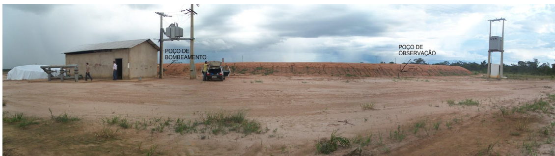
Foto 6 – Localização do poço de bombeamento 1 e seu poço de observação posicionado a 30 metros de distância.
