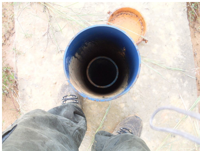
Foto 8 – Poço de observação no teste de bombeamento no poço 2.
