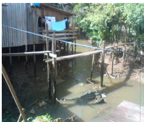
Figura 2. Ausência de saneamento básico, com matéria orgânica lançada diretamente no igarapé.
