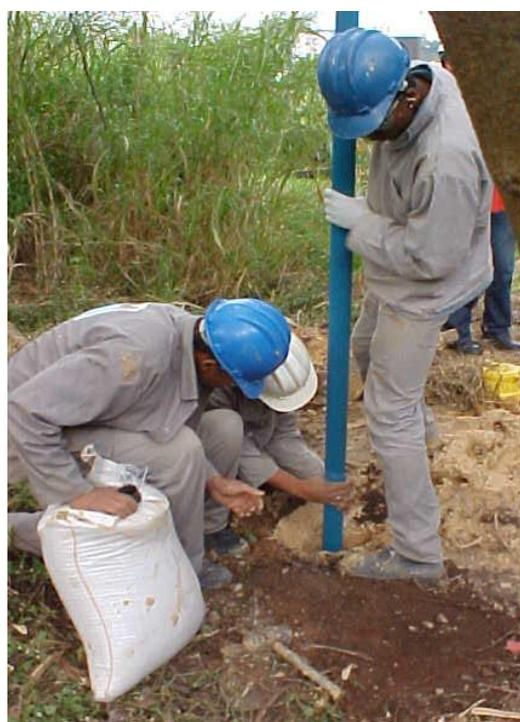
Fotos 2 e 3: Perfuração do solo e instalação de poço de monitoramento da água subterrânea (2ª etapa das investigações - 2007)
