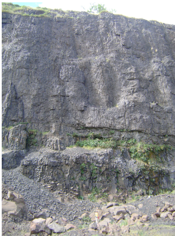
Figura 9. Fraturas sub-horizontais, por vezes com extensão mínima de várias centenas de metros, onde foram observadas saídas de água (AF11).
