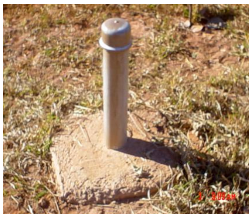
Figura 6: Detalhe da construção dos poços de monitoramento de água subterrânea..
