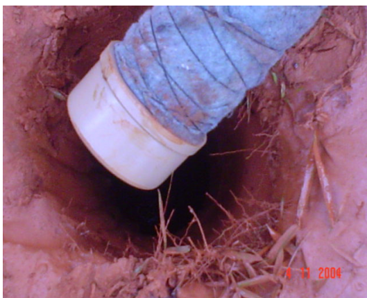
Figura 6: Detalhe da construção dos poços de monitoramento de água subterrânea..
