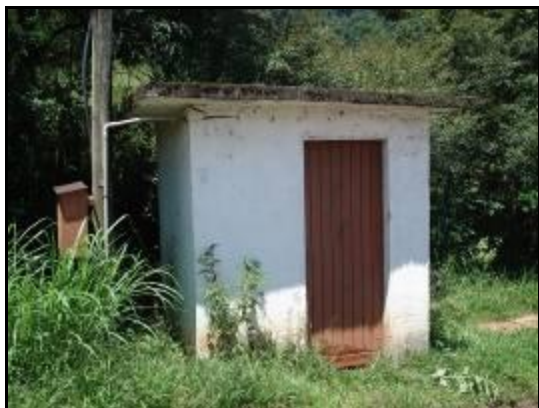
Figura 2a. Poço tubular Vila Cristina.
