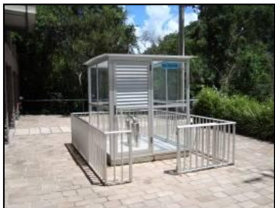
Figura 2c. Poço tubular Aventura.
