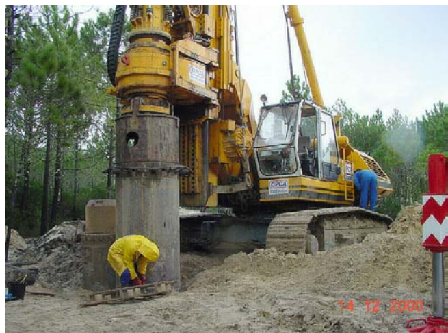
Figura 10 (ao lado) Aplicação de revestimento provisório de 1.20m até à máxima profundidade de furação.
