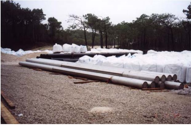
Figura 7 – (ao lado) Armazenagem local das colunas de captação pré montadas (diâmetro 0.30m) e “big bags” de areia siliciosa calibrada usada para as camadas de filtro.
