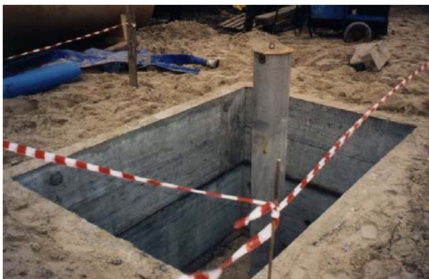
Figura 11 – (ao lado) Poço terminado, já dentro de caixa de protecção, durante a construção desta.
