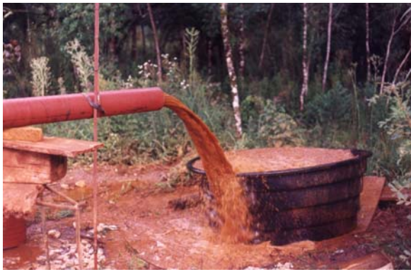
Figura 3F. Carreamento de material de preenchimento de cavidades subterrâneas durante o teste do poço P-17 (Fervida)
