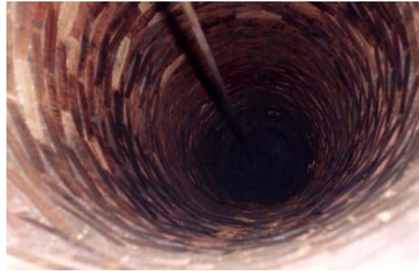
Figura 3B. Secamento de poço cacimba com 8 m de profundidade, atribuído ao bombeamento dos poços P-08 e P-08 (Tumiri)
