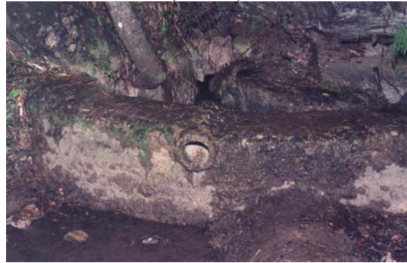
Figura 3D. Secamento de fonte na propriedade do Sr. Darci Poli, atribuído ao bombeamento do poço P-01 (Tumiri)
