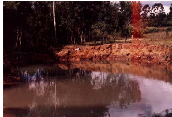
Figura 3G. Colapso de açude (dolina), em conseqüência do bombeamento do P-17 (Fervida) visto no canto superior direito da foto.
