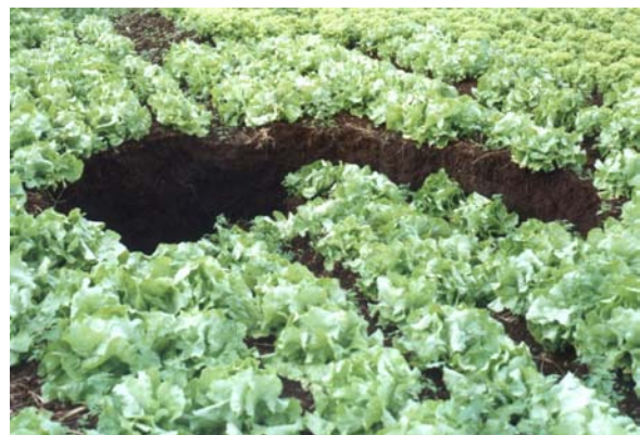
Figura 3J. Colapso de terreno com mais de 2 m de diâmetro na propriedade do Sr. Luís Cavalli, atribuído ao bombeamento do poço P-15 (Fervida)
