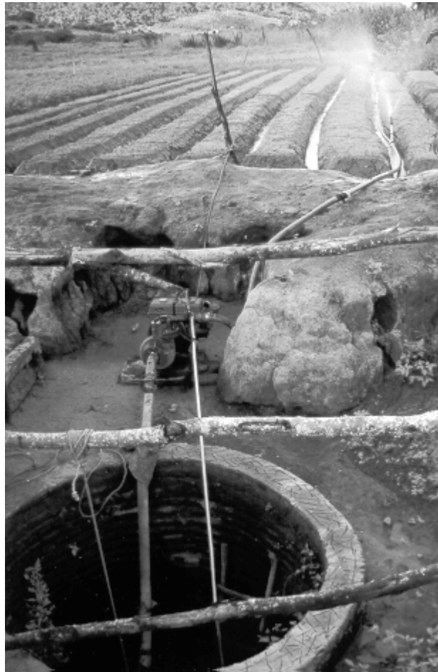
Figura 2. Captação de água do aquífero aluvial para suprimento da irrigação (aspersão).
