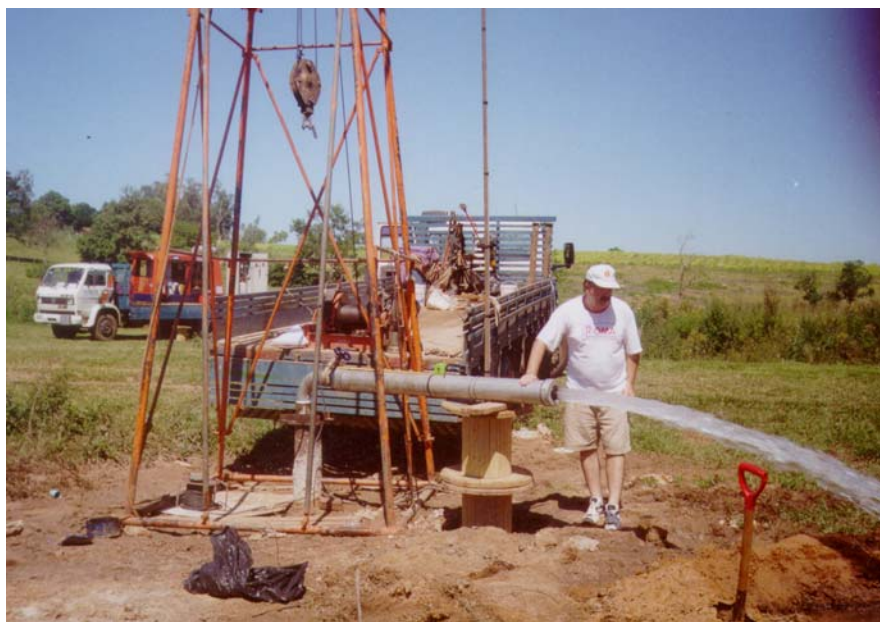
Figura 05 – Poço 02 em fase de testes
