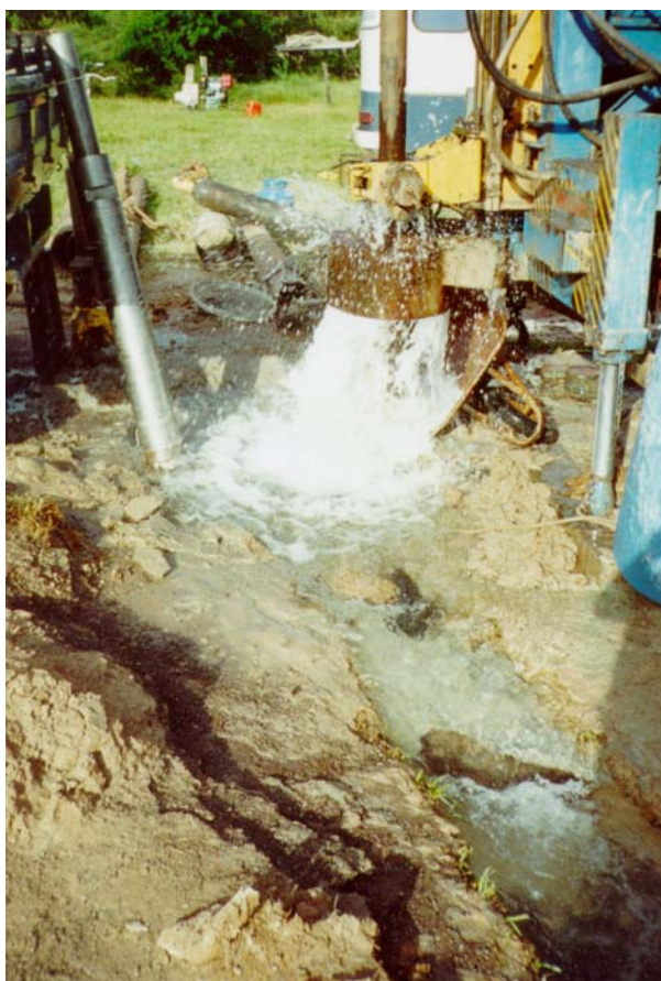
Figura 04 – Poço 01 em fase de perfuração
