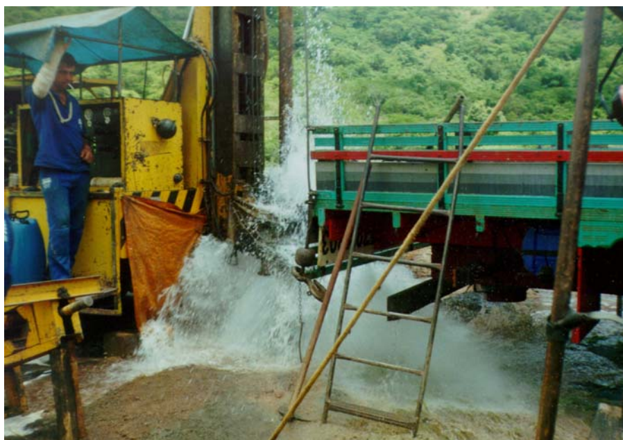
Figura 06 – Poço 03 em fase de perfuração
