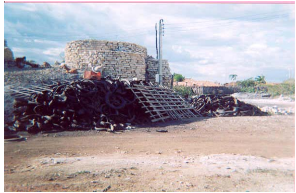
Foto 2: Caeira localizada na comunidade de Sucupira em Limoeiro. do Norte - Ce.
