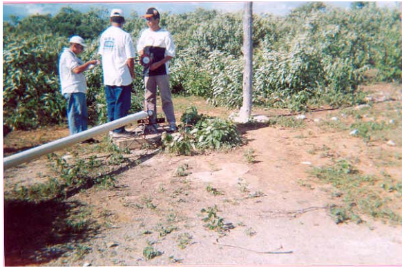
Foto 1: Poço tubular abandonado na comunidade de Viração em Limoeiro do Norte – Ce.
