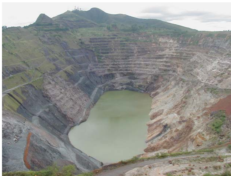
Figura 7 e 8 . Apresentam a evolução do enchimento da cava de dezembro de 1999 a maio de2002.
