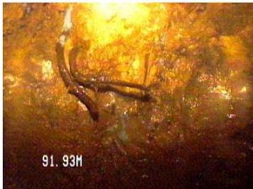
**FOTOGRAMA B** - Visada lateral do final da sapata de contato entre o tubo e a rocha aos 91,93 metros.
